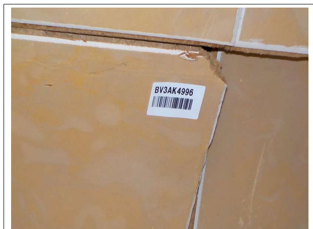
Prélèvement - P12 : Bâtiment principal / RDC / Circulation Est - Faux plafond- (Absence d'amiante)
