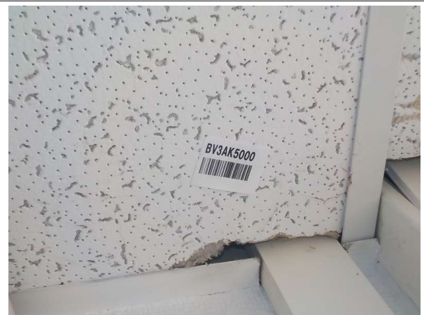
Prélèvement - P16 : Pavillon SAIO / RDC / Circulation - Faux plafond- (Absence d'amiante)
