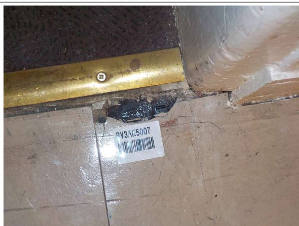
Prélèvement - P23 : Bâtiment principal / R+1 / Local 133 - Dalle de sol- (Présence d'amiante)
