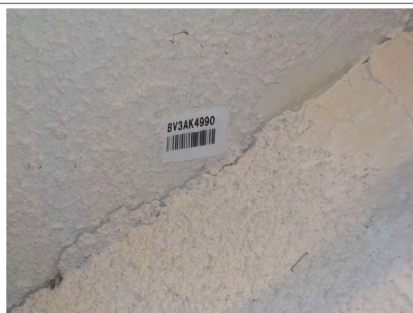
Prélèvement - P6 : Bâtiment principal / R-1 / Local D1 - Enduit projeté- (Absence d'amiante)
