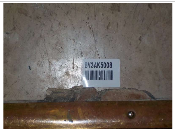
Prélèvement - P24 : Bâtiment principal / R+1 / Local 102-1 - Dalle de sol- (Présence d'amiante)
