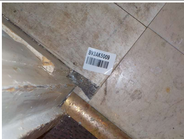
Prélèvement - P25 : Bâtiment principal / R+1 / Local 102-1 - Dalle de sol - EP- (Présence d'amiante)
