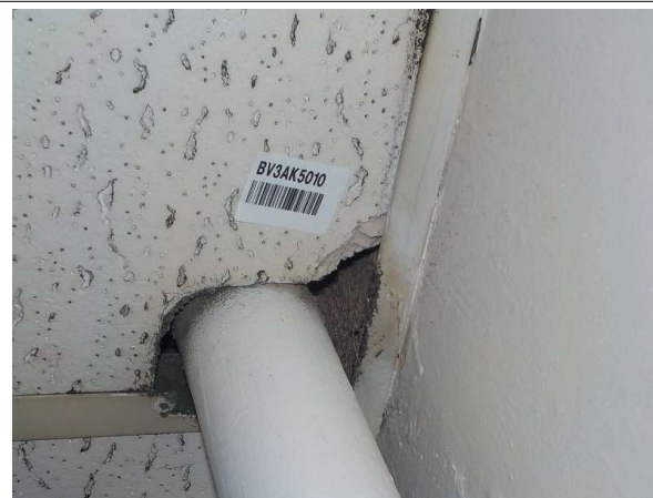
Prélèvement - P26 : Bâtiment principal / R+2 / Dégagement - Faux plafond- (Absence d'amiante)
