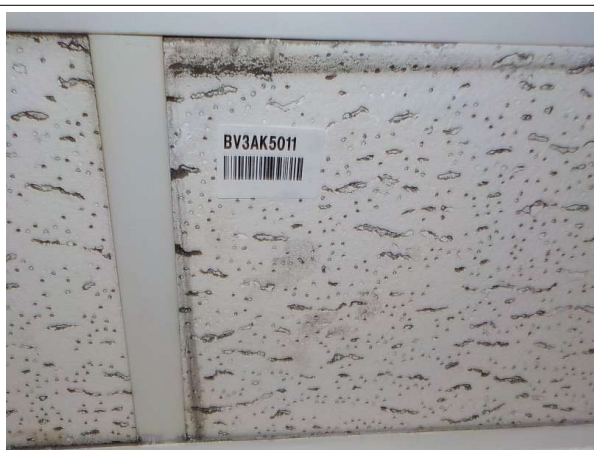
Prélèvement - P27 : Bâtiment principal / R+3 / Dégagement - Faux plafond- (Absence d'amiante)
