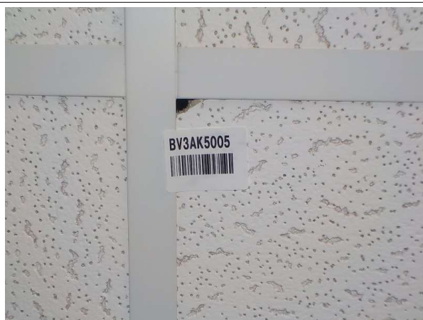
Prélèvement - P21 : Bâtiment principal / R+1 / Bureau 134/136 - Faux plafond- (Absence d'amiante)
