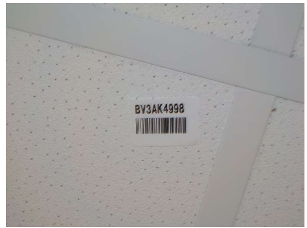
Prélèvement - P14 : Bâtiment principal / RDC / Circulation Nord - Faux plafond- (Absence d'amiante)
