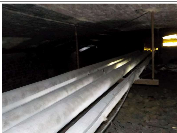
Prélèvement - P3 : Bâtiment principal / R-1 / Vide sanitaires A0A081 - Enveloppe de calorifugeage- (Absence d'amiante)
