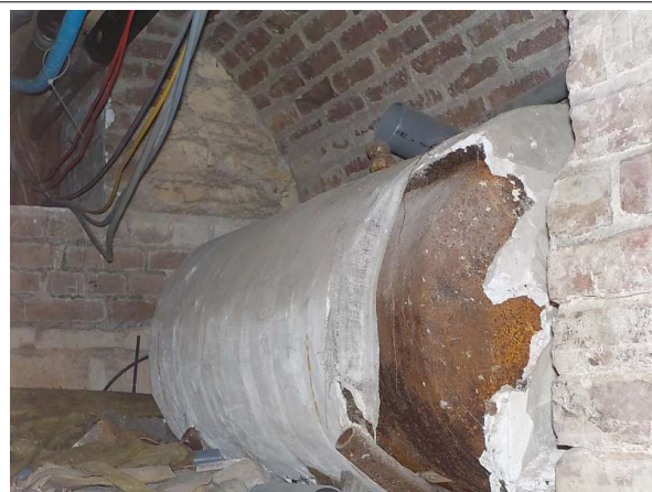
Prélèvement - P2 : Bâtiment principal / R-1 / Vide sanitaires A0A053 - Enveloppe de calorifugeage- (Absence d'amiante)
