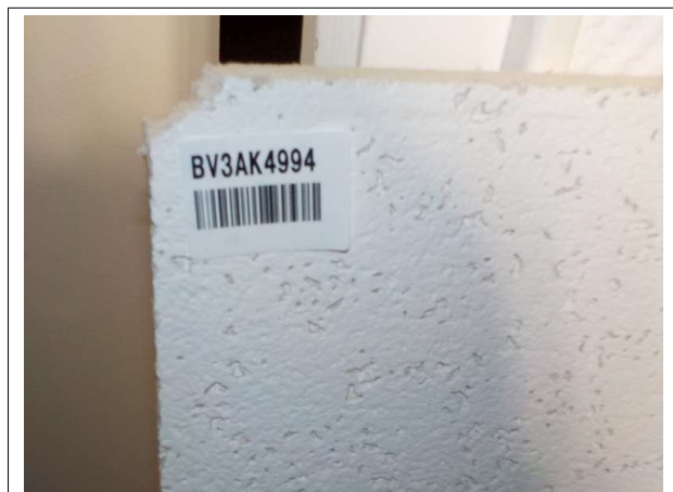
Prélèvement - P10 : Bâtiment principal / RDC / Service médical / Entrée - Faux plafond- (Absence d'amiante)
