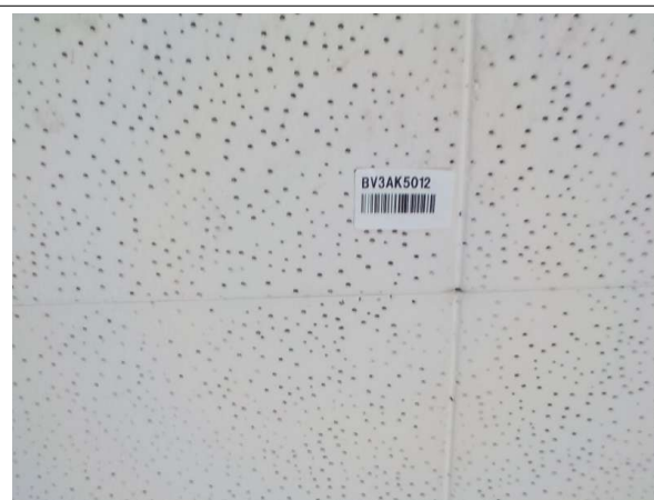
Prélèvement - P28 : Bâtiment principal / R+3 / Bureau 303 - Faux plafond- (Absence d'amiante)
