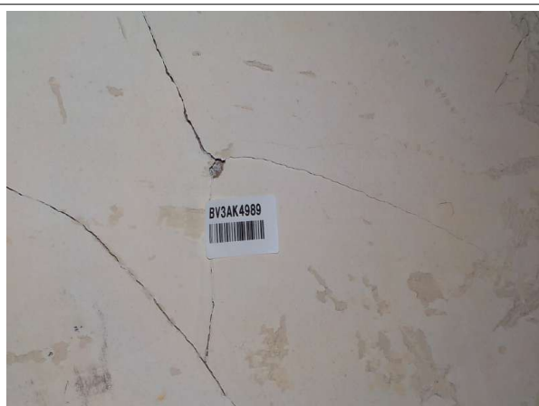
Prélèvement - P5 : Bâtiment principal / R-1 / Local IPET SAIA - Enduit projeté- (Absence d'amiante)
