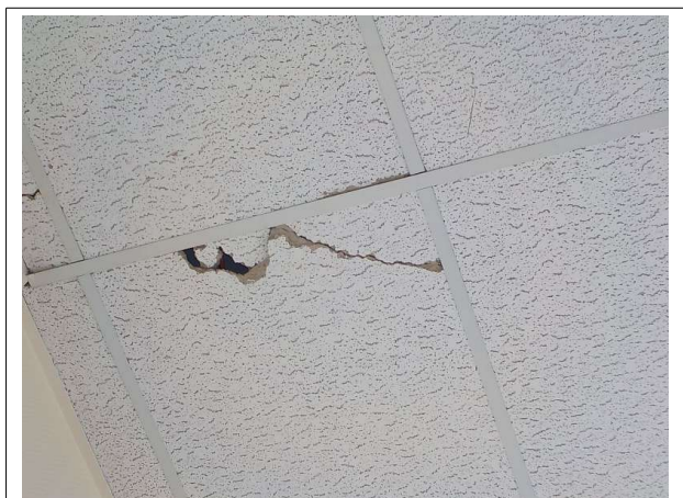
Prélèvement - P9 : Bâtiment principal / RDC / Circulation Est A00116 - Faux plafond- (Absence d'amiante)
