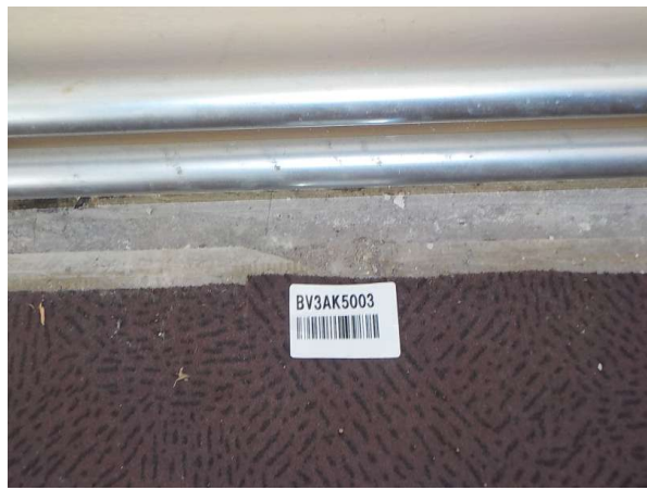
Prélèvement - P19 : Bâtiment principal / R+1 / Circulation Nord - Dalle de sol - EP- (Présence d'amiante)
