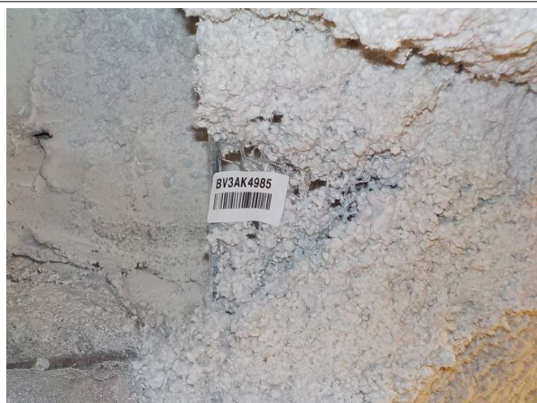
Prélèvement - P1 : Bâtiment principal / R-1 / Chaufferie - Flocage- (Absence d'amiante)
