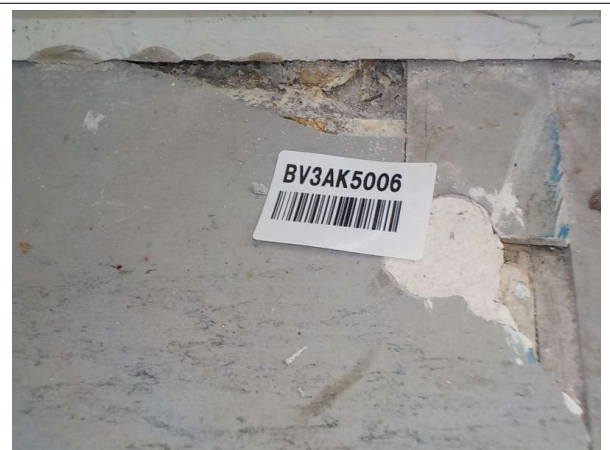
Prélèvement - P22 : Bâtiment principal / R+1 / Bureau 134/136 - Dalle de sol- (Absence d'amiante)
