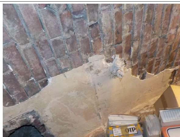
Prélèvement - P4 : Bâtiment principal / R-1 / Local BAPF - Enduit projeté- (Absence d'amiante)
