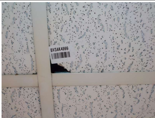
Prélèvement - P15 : Bâtiment principal / RDC / DEC 1 / Bureau 009 - Faux plafond- (Absence d'amiante)
