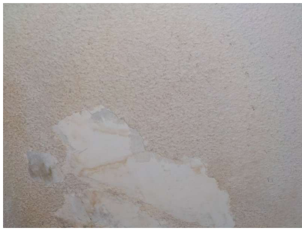
Prélèvement - P13 : Bâtiment principal / RDC / Amphi - Flocage - (Absence d'amiante)
